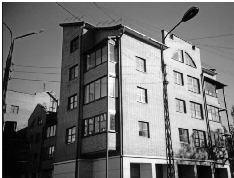
Жилой дом на Первомайском проспекте
